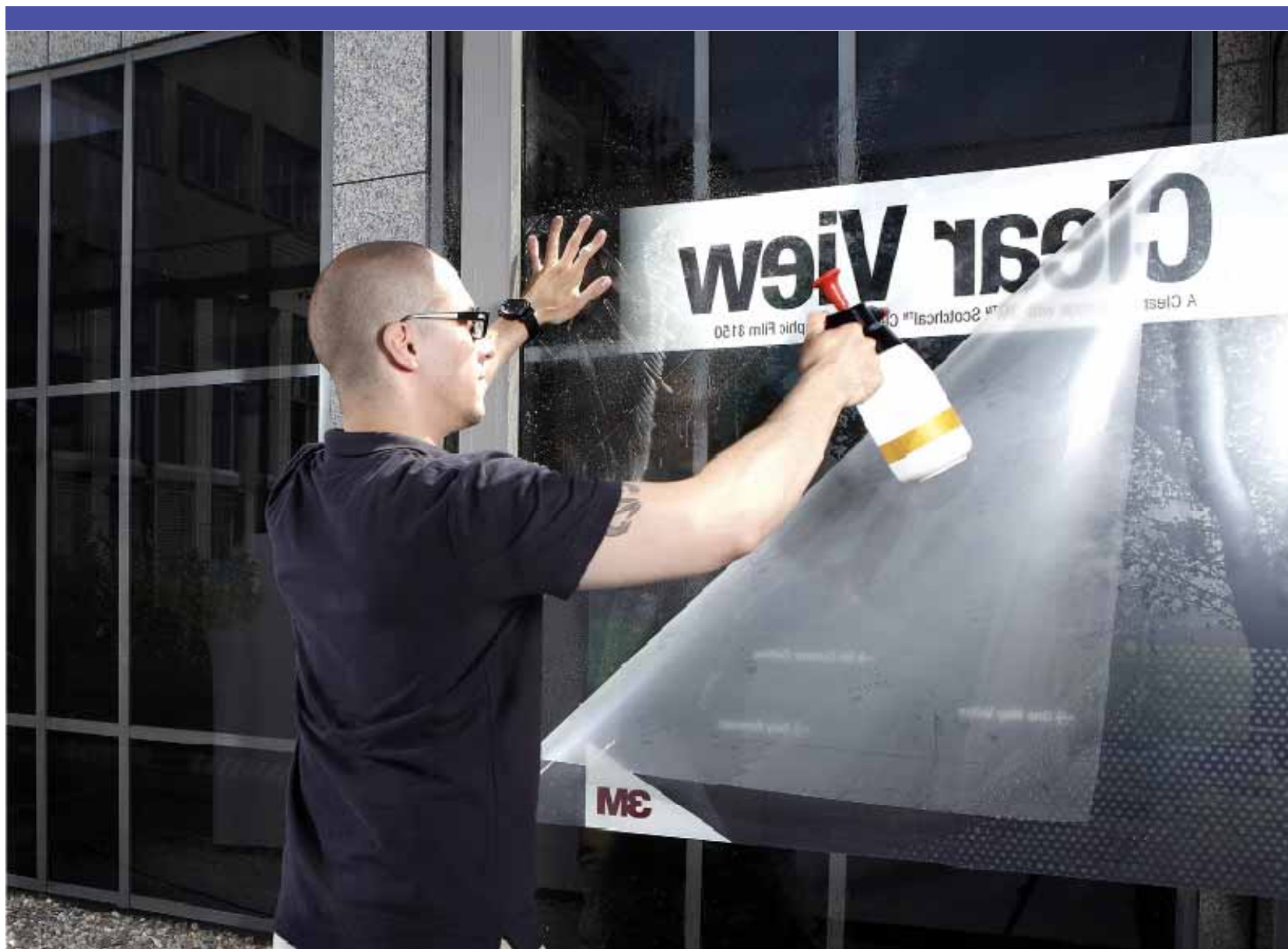
Prawidłowy sposób aplikacji na mokro folii graficznej 3M™ Scotchcal™ Clear View Graphic Film 8150 | Etap 8
