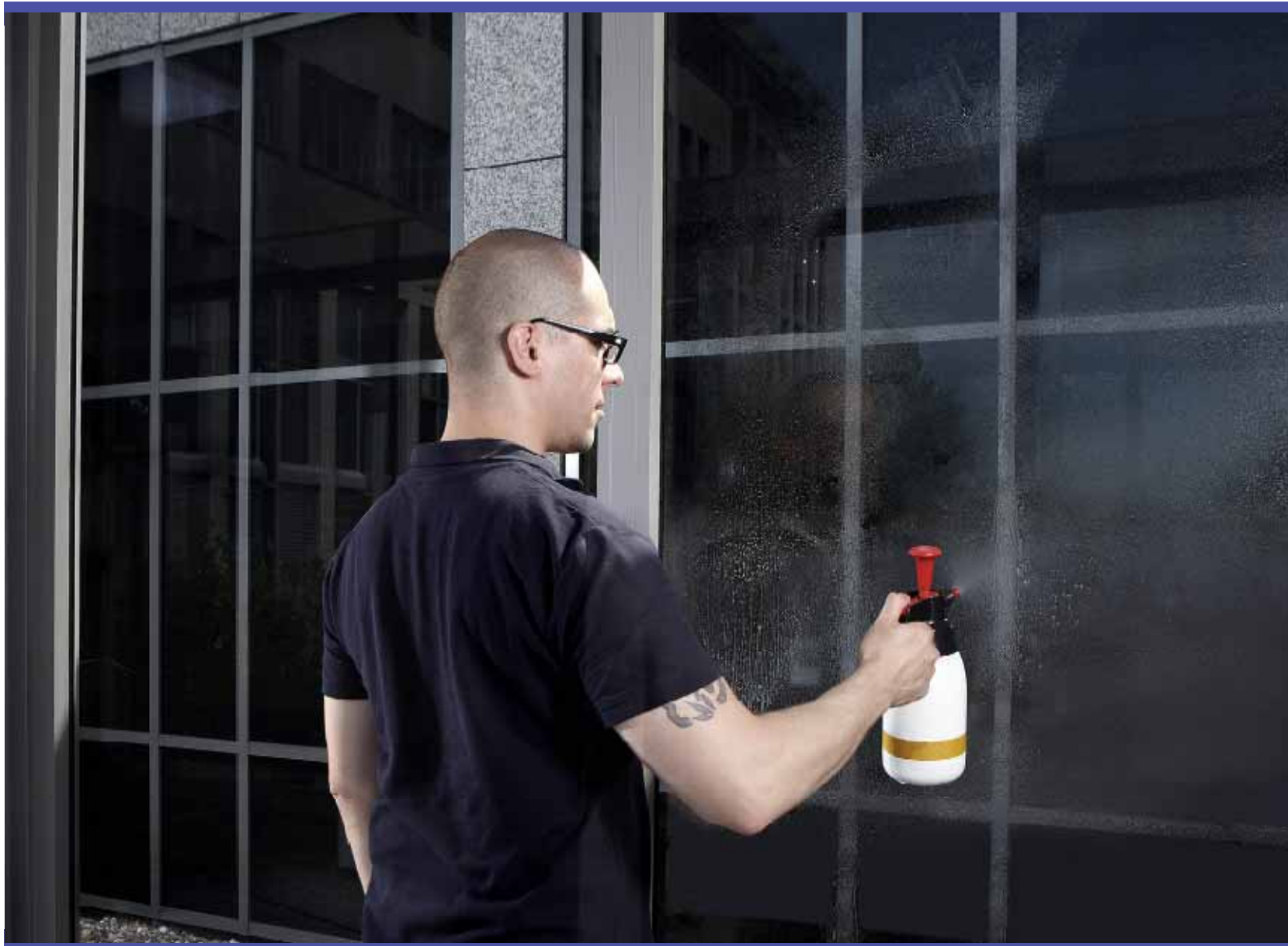
Prawidłowy sposób aplikacji na mokro folii graficznej 3M™ Scotchcal™ Clear View Graphic Film 8150 | Etap 5
