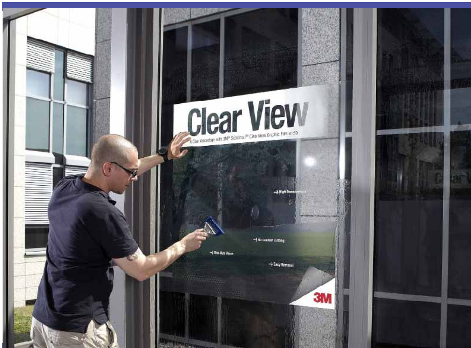
Prawidłowy sposób aplikacji na mokro folii graficznej 3M™ Scotchcal™ Clear View Graphic Film 8150 | Etap 16
