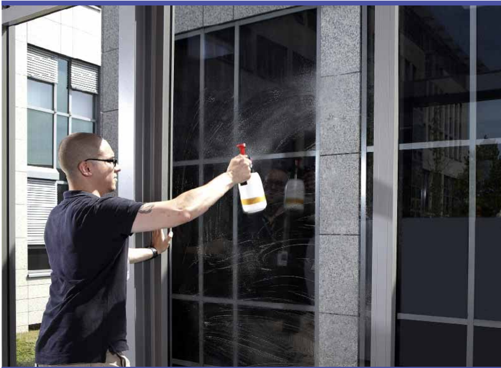
Prawidłowy sposób aplikacji na mokro folii graficznej 3M™ Scotchcal™ Clear View Graphic Film 8150 | Etap 3
