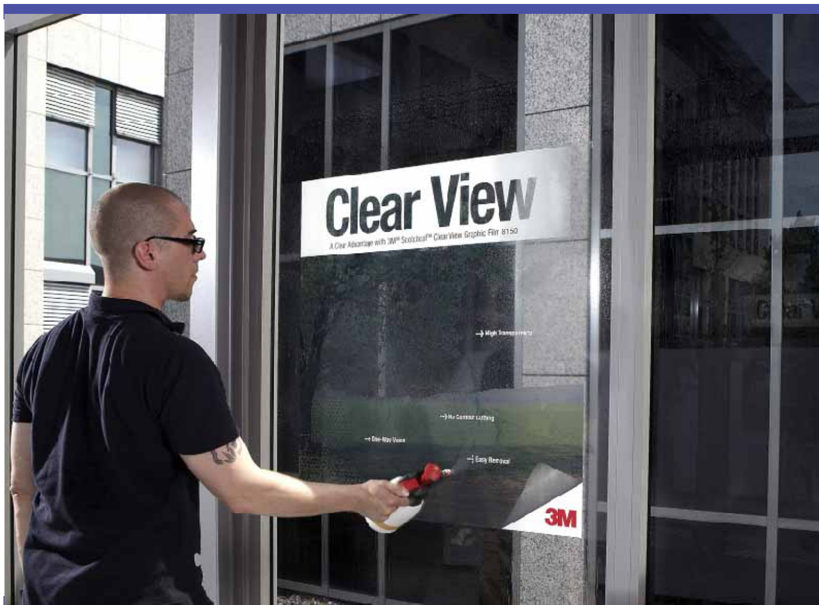
Przedstawiony sposób aplikacji na mokro folii graficznej 3M™ Scotchcal™ Clear View Graphic Film 8150 | Etap 18
