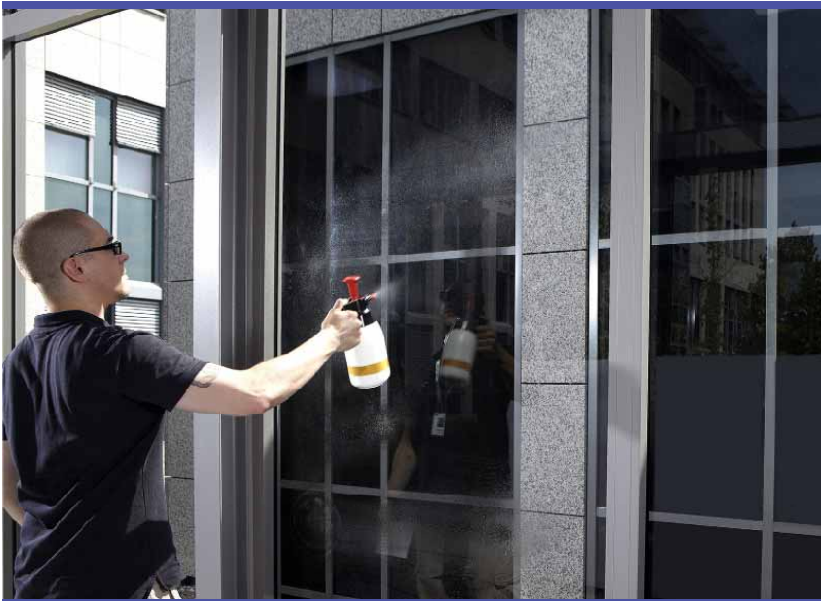
Prawidłowy sposób aplikacji na mokro folii graficznej 3M™ Scotchcal™ Clear View Graphic Film 8150 | Etap 1
