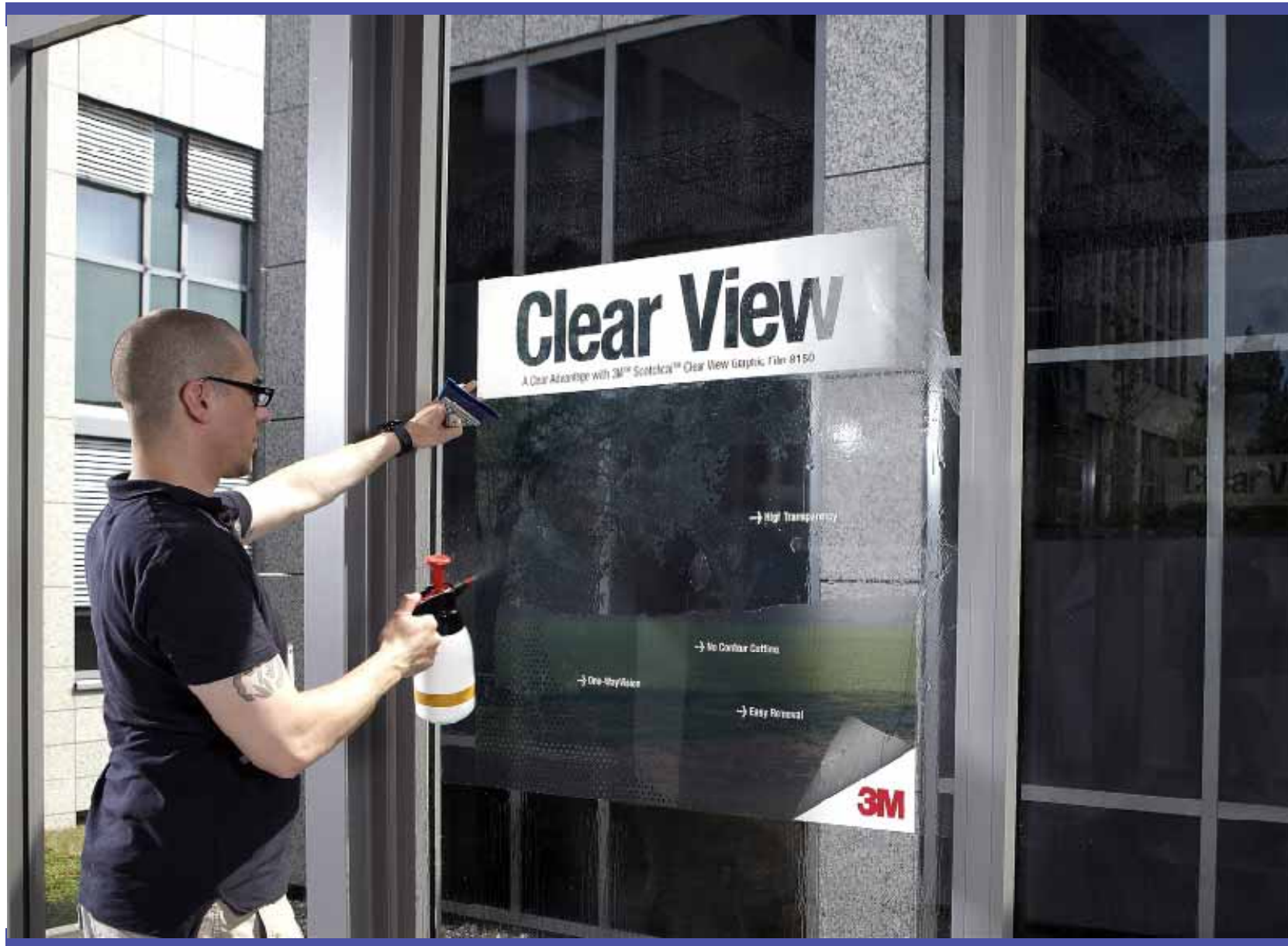
Prawidłowy sposób aplikacji na mokro folii graficznej 3M™ Scotchcal™ Clear View Graphic Film 8150 | Etap 15
