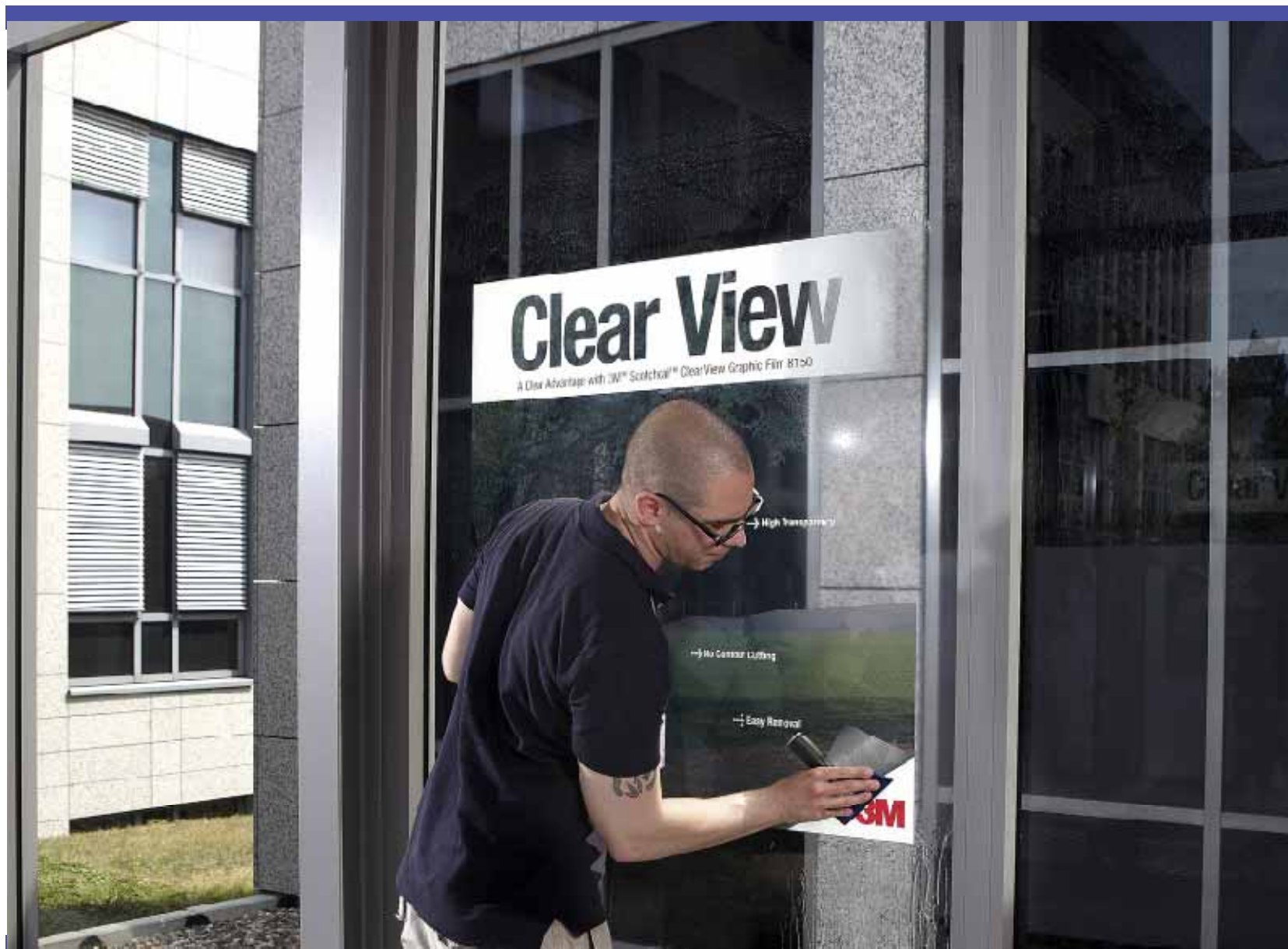
Przedstawiony sposób aplikacji na mokro folii graficznej 3M™ Scotchcal™ Clear View Graphic Film 8150 | Etap 17
